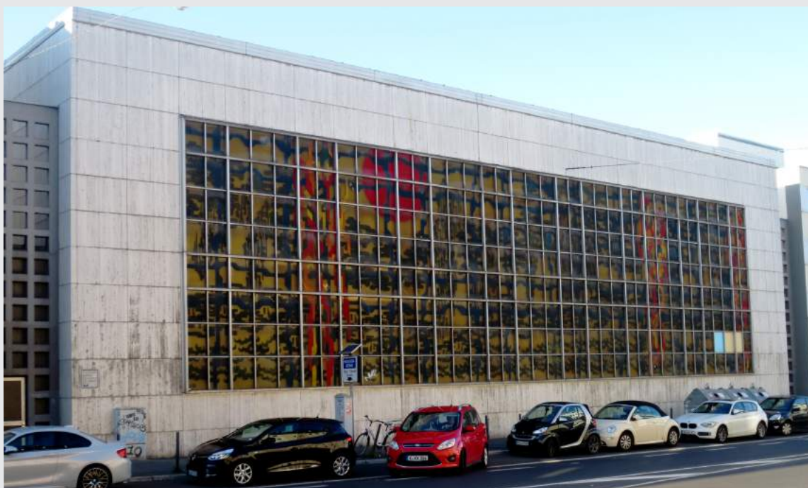
Ehemaliges Viktoriabad, Fassade am Belderberg mit Kunstharzfenster
