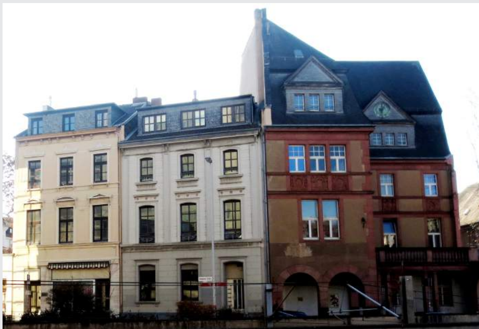
Leerstehende Häuser an der Budapester Straße 19 und 21 (im Bild links)
